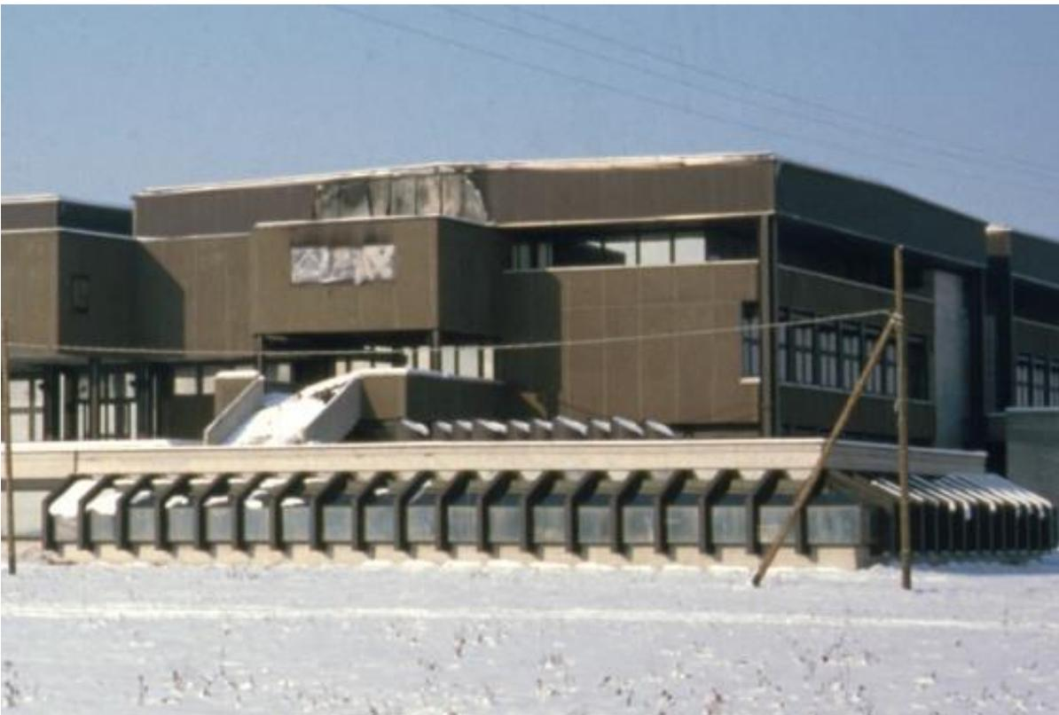
**FIGURA 27.** Ingrandimento di figura 26 che evidenzia i danni esterni all'edificio dovuti all'incendio.
